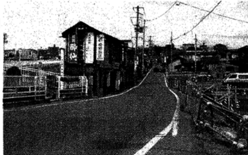
開削ではなく推進工法で最長記録に認定された下水管が埋設される盛岡市神子田町地内の市道の工事起点(南大橋側から撮影)
